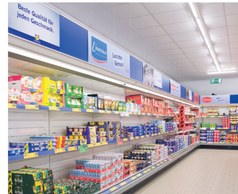
Nutzung der Abwärme zur Beheizung der Filiale
